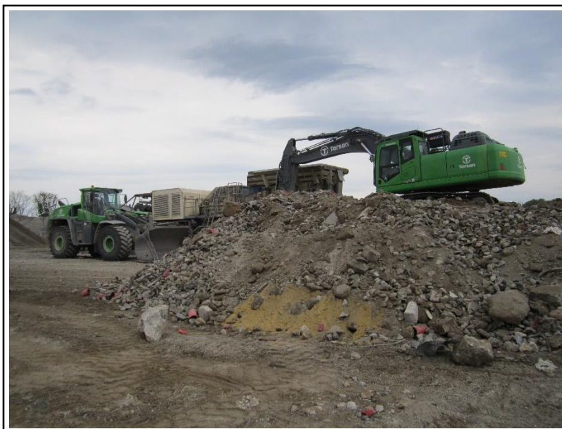
Installation de recyclage de matériaux de démolition.
